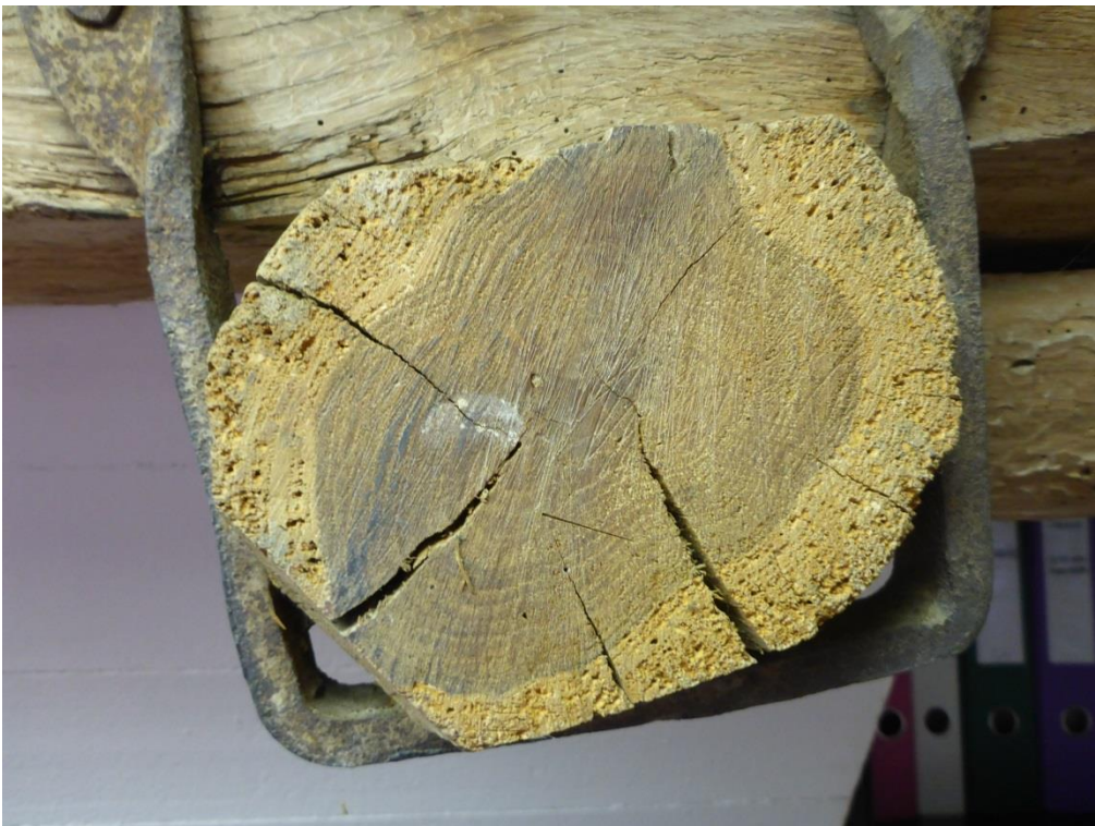
Eikenhout met spint dat zichtbaar is als een band lichter hout, vaak aangetast door houtworm. Helaas heeft dit hout te weinig jaarringen voor dendrochronologisch onderzoek.
