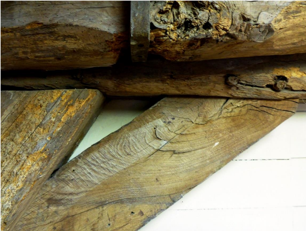
Eikenhout met vergroeiingen in het jaarringenpatroon als gevolg van een takaanzet is ongeschikt voor dendrochronologisch onderzoek. Links een deel eikenhout met spint dat is aangetast door houtworm.
